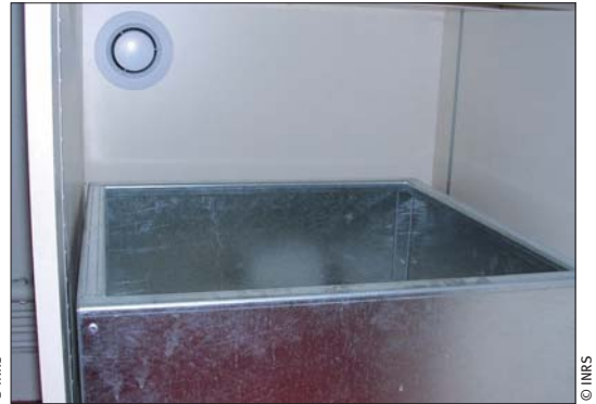
Figures 49 à 51. Captage des vapeurs au-dessus d'un conteneur pour déchets chimiques.
