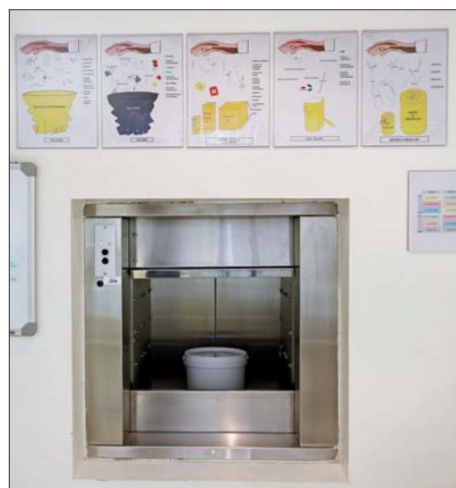
Figure 47. Un monte-charge permet d'amener rapidement les échantillons de la salle d'opération au laboratoire d'ACP.
