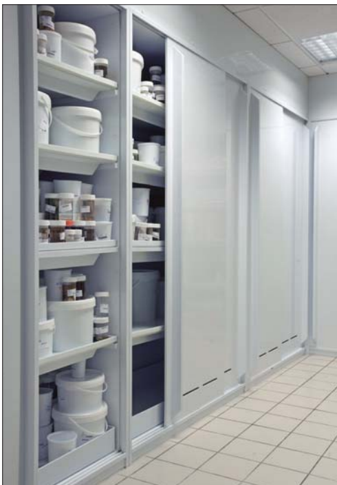
Figures 59 et 60. Les récipients contenant les pièces fixées dans le formol sont stockés dans des armoires ventilées, disposant d'étagères munies d'un dispositif de rétention.
