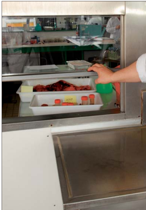
Figure 64. Les échantillons issus de l'autopsie sont amenés dans la pièce de microbiologie par l'intermédiaire d'un « passe-plat » situé entre les deux salles.
