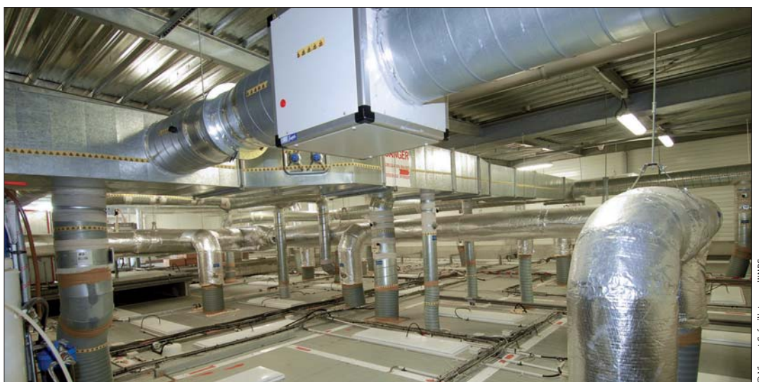
Figure 34. Système de ventilation et de filtration d'air au-dessus de salles techniques de niveau de confinement 3.
