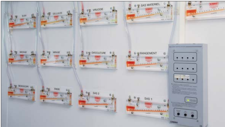
Figure 33. Contrôle des niveaux de pression des sas et des salles techniques.
