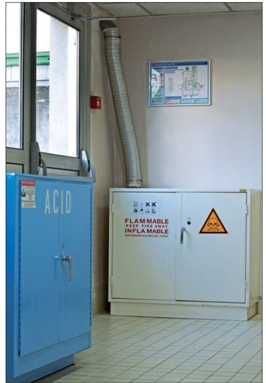
Figure 43. Des enceintes spécifiques aux acides ou des enceintes ventilées pour les produits inflammables sont nécessaires pour stocker les produits dans les salles techniques.
