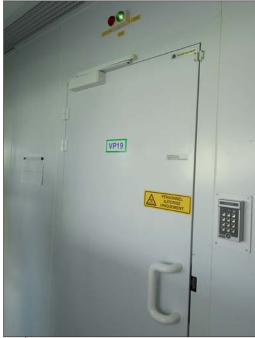
Figure 31. Accès contrôlé au laboratoire par un sas.
