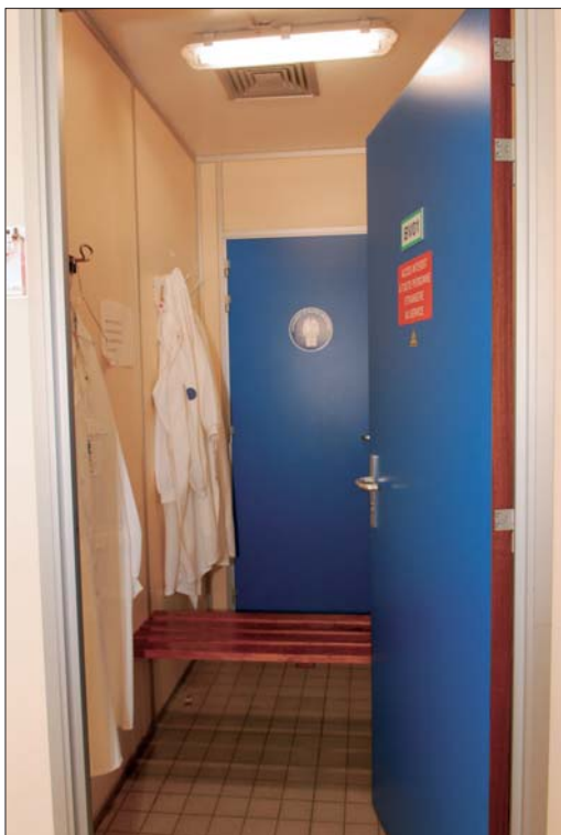
Figure 36. Sas avec un banc séparant deux zones.
