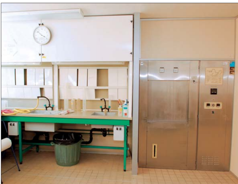
Figure 44. La laverie est équipée d'éviers pouvant être placés sous hotte aspirante. Un autoclave double entrée (à droite) relie la laverie au laboratoire de niveau de confinement 3.
