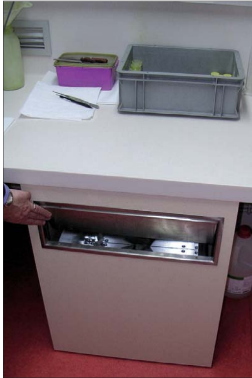
Figures 49 à 51. Captage des vapeurs au-dessus d'un conteneur pour déchets chimiques.
