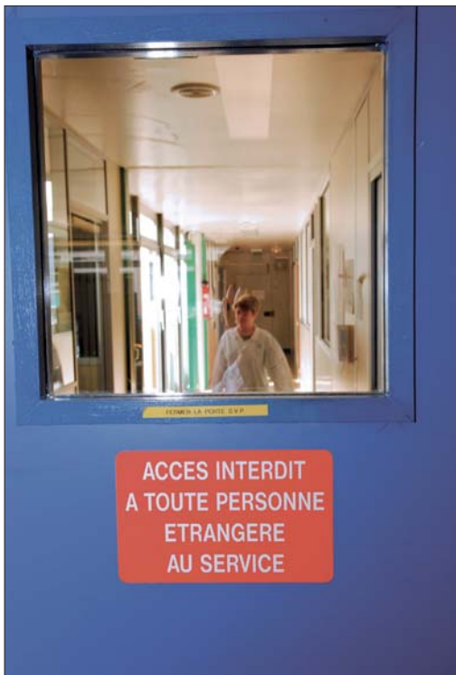
Figure 16. Portes permettant une bonne visibilité des personnes dans le laboratoire.
